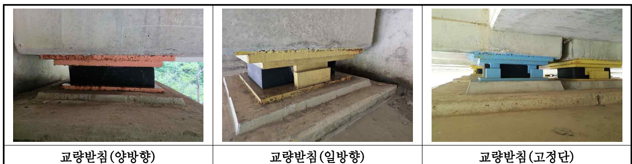
【사진 9.3.13】 교량받침 전경
