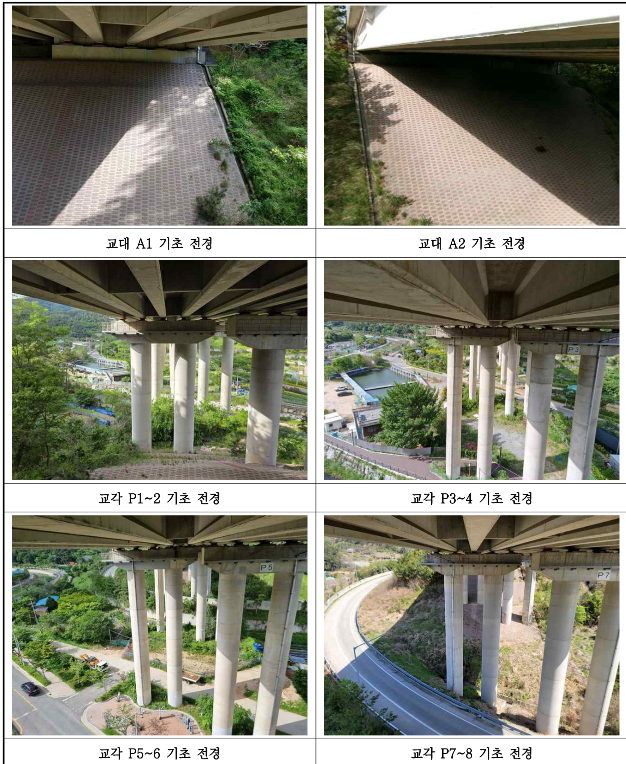
【사진 9.3.12】 기초 전경
