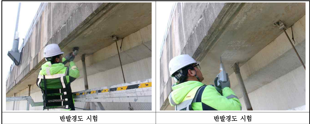
【사진 9.4.2】 반발경도시험 현장사진
