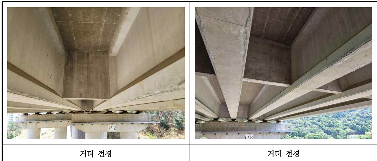
【사진 9.3.4】 거더 전경
