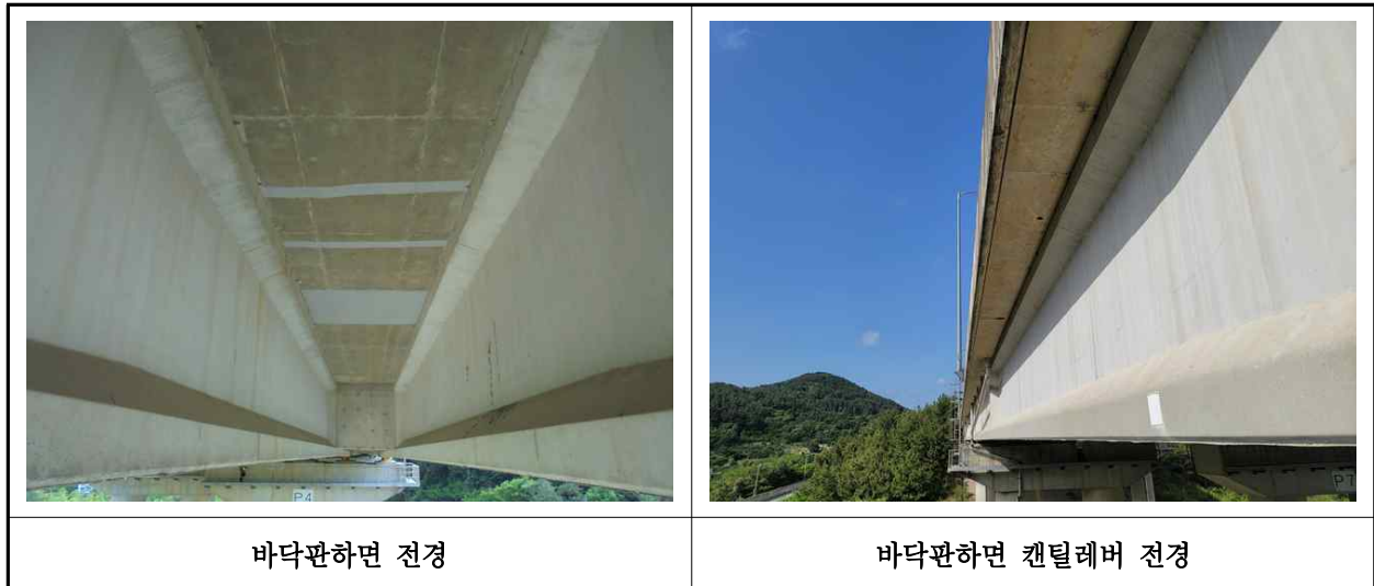
【사진 9.3.2】 바닥판하면 전경
