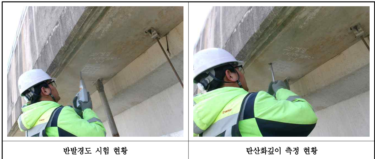
【사진 9.4.1】 콘크리트 내구성조사 현황
