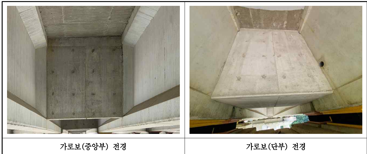
【사진 9.3.6】 가로보 전경
