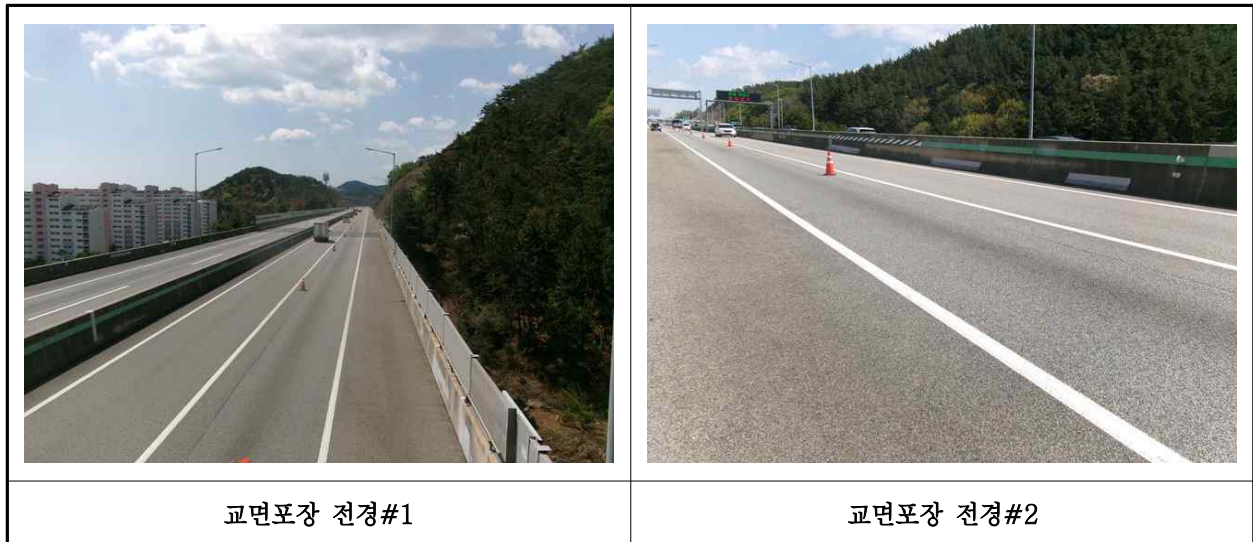
【사진 9.3.20】 교면포장 전경
