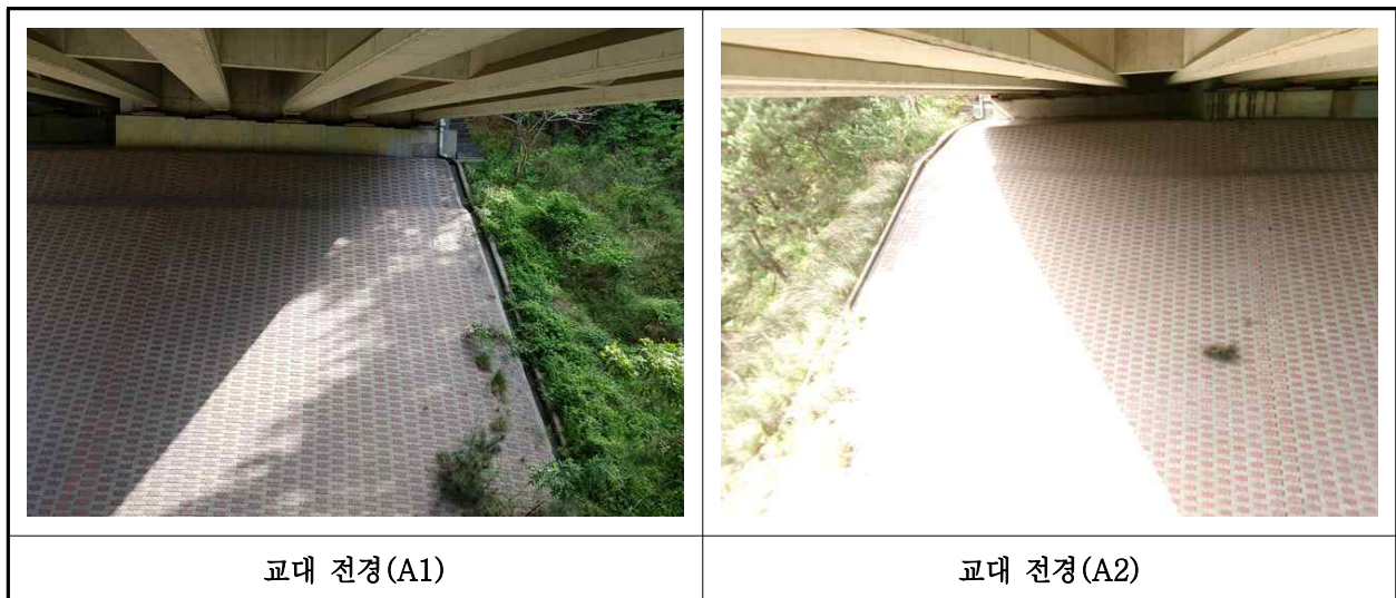
【사진 9.3.8】 교대 전경
