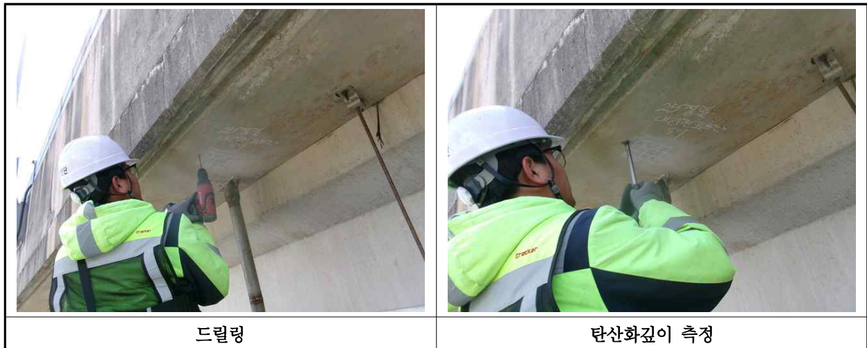
【사진 9.4.3】 탄산화 깊이 측정 현장사진
