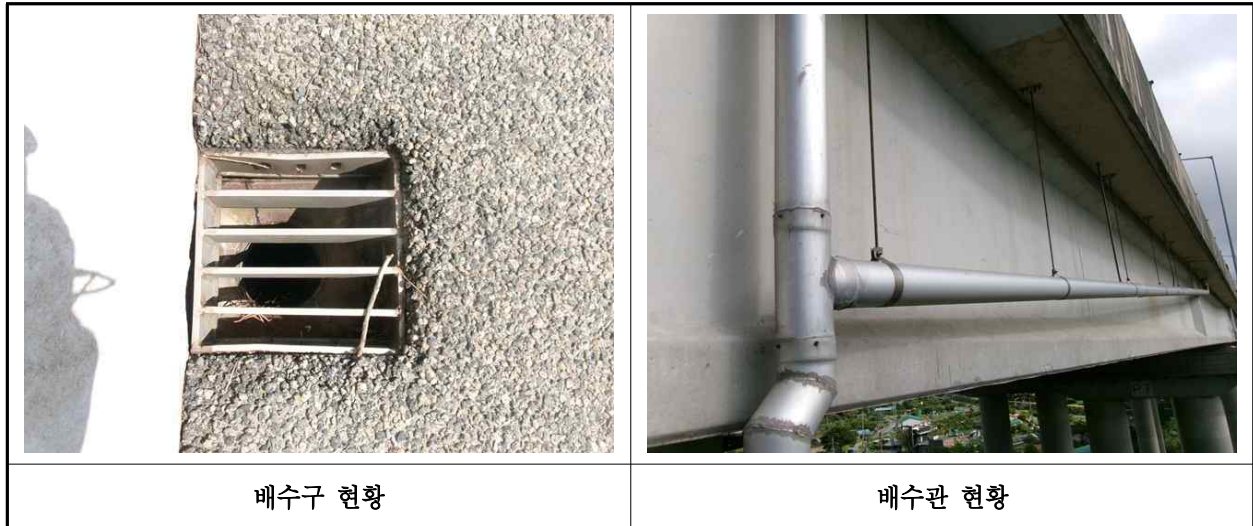
【사진 9.3.22】 배수시설 전경
