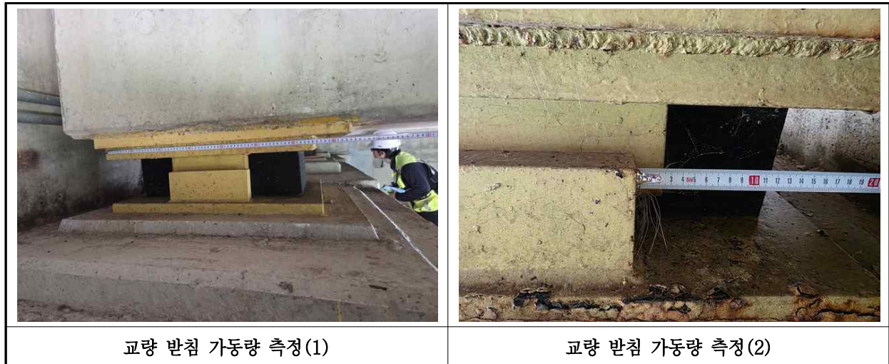
【사진 9.3.16】 교량받침 이동량 측정
