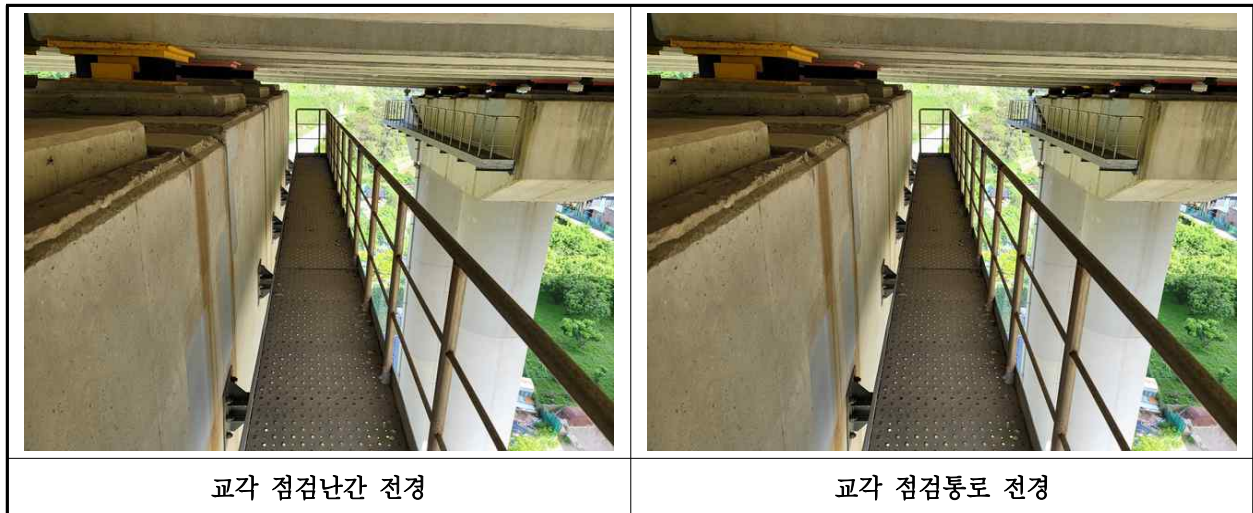
【사진 9.3.26】 교량 점검시설 전경
