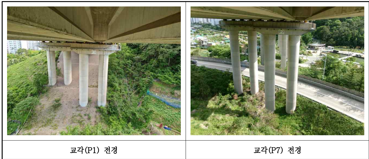
【사진 9.3.10】 교각 전경
